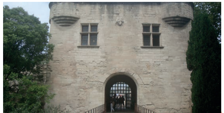
PORTARIA DA PONTE
