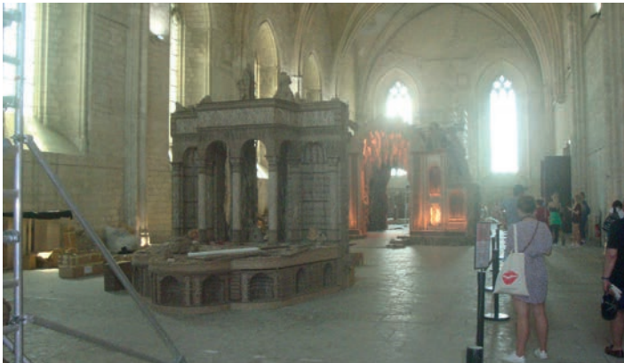
CAPELA PRINCIPAL (EM RESTAURO)
